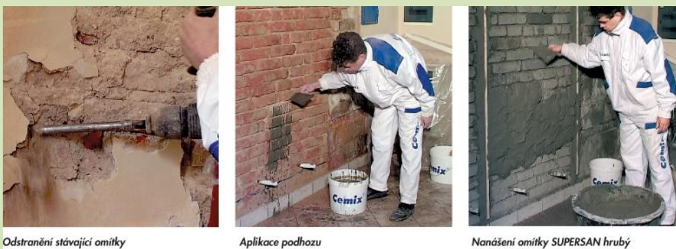
Odstranění stávající omítky
